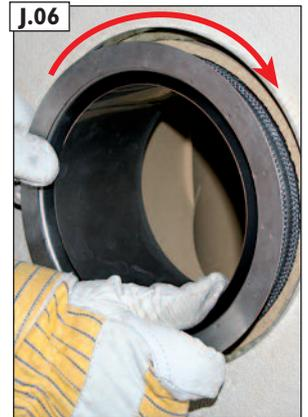
Anschlussfutter mit aufgewickeltem Keramikdichtband in das Schamotteanschlussformstück in Wickelrichtung hineindrehen.
