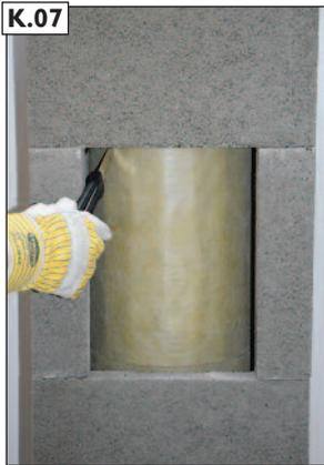
Vordere erreichbare Dämmschicht mit Cuttermesser freischneiden.
