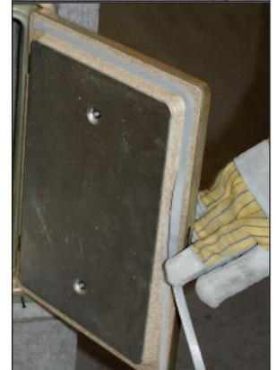
Spezialaußendichtung wird auf den Rahmen und das Türblatt geklebt.
