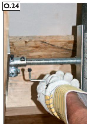
Gewindestange fixieren. Dazu die Abreißschrauben an beiden Sparrenhaltern mit Inbusschlüssel (E) anziehen bis der Schraubkopf an der Sollbruchstelle abreißt.
