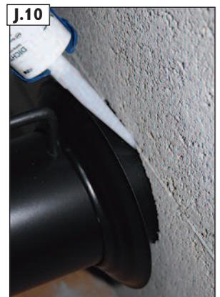
Die Zuluftleitung an der Öffnungsbohrung im Schornstein muss bauseitig abgedichtet werden.
