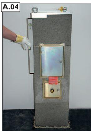
A.04 Fertigfuß in Mörtel MG(M5) IIa (Mauermörtel nach EN 998-2) versetzen und lotrecht ausrichten.
