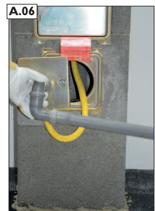
A.06 Kondensatableitung zum Abwasserkanal bauseits herstellen (HT-Rohr DN40 bauseits bereitstellen).
