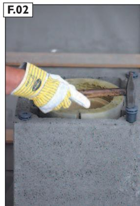
**F.02** HEB-Spezialdübel in die Bewehrungskanäle des Mantelsteins einschlagen.
