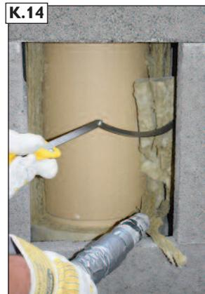
Seitlichen Dämmstoff mit dem 1/4-Kreis Dämmstoffschaber entfernen.
