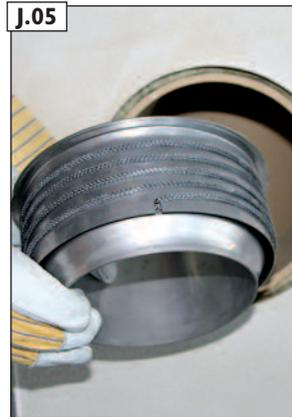
Keramikdichtband spiralförmig und straff um das Anschlussfutter wickeln.
