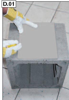
RA-Schnittschablone aus dem BlowerDoor-Set außen anlegen, Mantelsteinöffnung anzeichnen.
