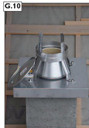
Der Revisionsdeckel ist mit einer Drahtschlinge, als „Absturzsicherung“, verbunden. Die Drahtschlaufensicherung mind. einmal im Jahr überprüfen und ggf. erneuern.
