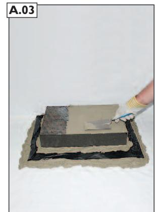
A.03 Mörtelbettaufbau bei ergänzender Verwendung der Thermofußplatte (nicht im Lieferumfang enthalten).
