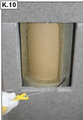
Das 1/4-Kreis Gelenk-Dämmstoffmesser ansetzen.
