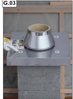
Silikondichtungen auf Zuluftkopfplatte-Edelstahl auflegen. Regenhaube „EAGLE“ aufsetzen.
