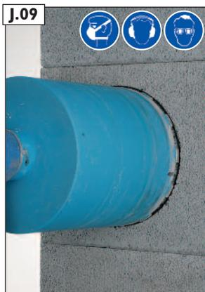
Den Zuluftanschluss individuell durch Mantelsteinbohrung bauseits herstellen.
