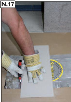
Spezial-Alugewebefolie kann bei Bedarf zugeschnitten werden. Mindestüberdeckung zur Mantelsteinöffnung beträgt 20 mm.
