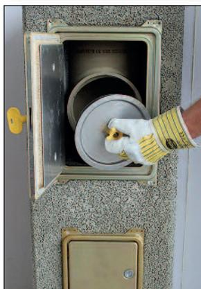
Putztür öffnen und Revisionsverschluss abnehmen. (Bild Darstellung am Beispiel Revisionsverschluss „B“)
