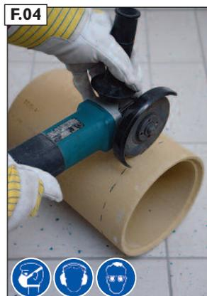
**F.04** An der Nutseite des Schamotterohres anzeichnen und mit Winkelschleifer zuschneiden.
