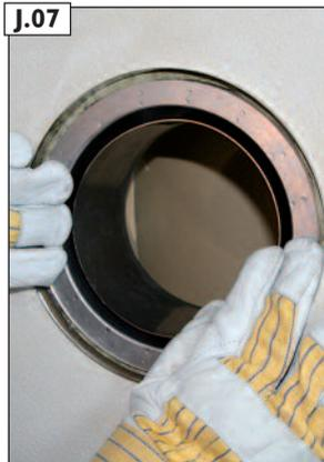
Anschlagring des Anschlussfutters muss dicht am Schamottestutzen angedrückt sein.
