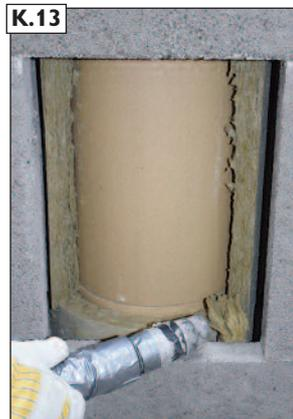
Zuluftkanäle von Dämmstoffresten freihalten.
